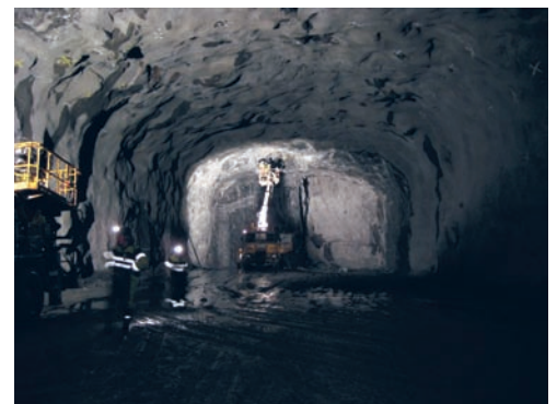
检查机房中的施工
