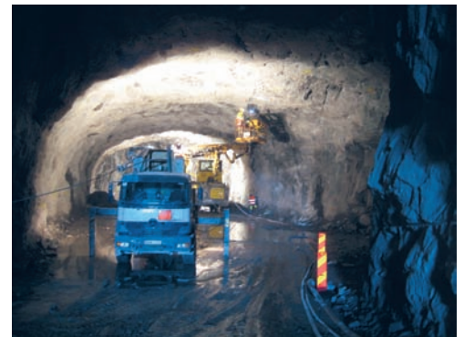
水蓄冷站内部
