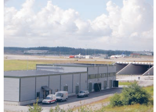
区域供冷生产站距离航站楼 1.5 km
