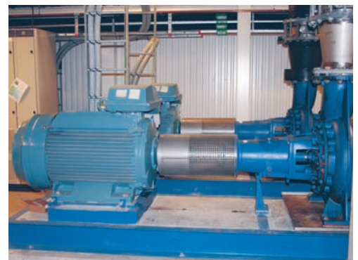
采用变频控制分配泵，用以将电耗降低到最低
